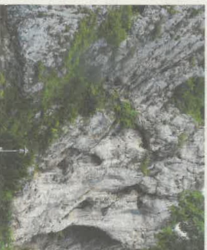
in die ae abgebaut wird. Dort können die Felssicherungsarbeiten durchgeführt werden.
